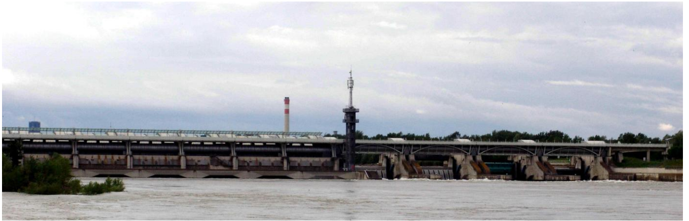
Die Staumauer in der Donau. Rechts beginnt die bewaldete Donauinsel.
